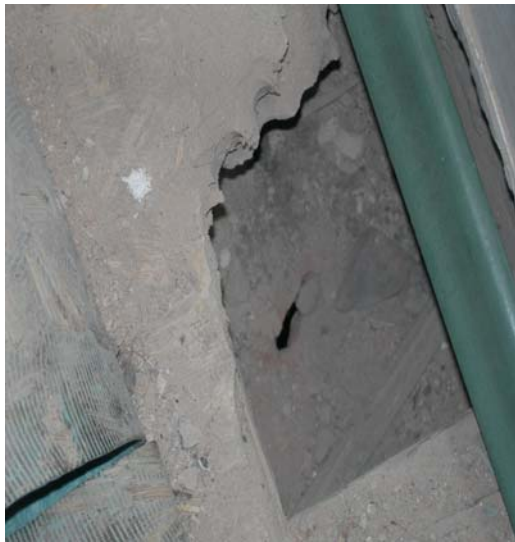
Zdjęcie nr 1. Odkrywka ujawniająca uszkodzenia stropu pod częścią pomieszczeń rozdzielni listów (pomieszczenia zostały w trakcie kontroli wyłączone z eksploatacji).
