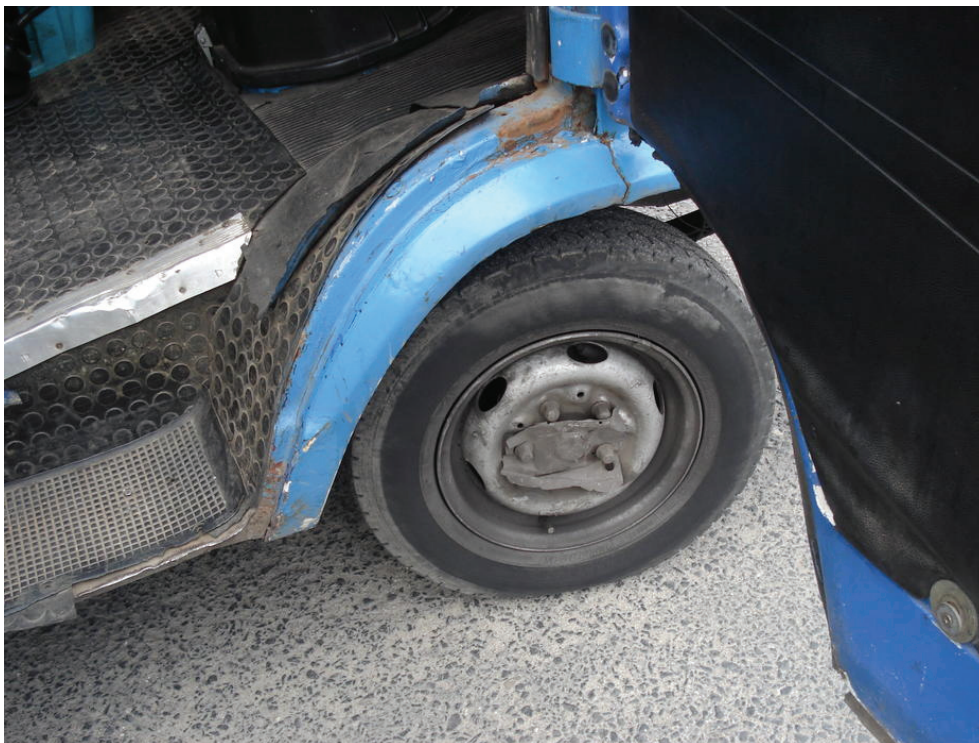
Zdjęcie nr 1 Nieprofesjonalne wykonanie napraw spawalniczych skutkujące uszkodzeniami elementów konstrukcyjnych.
