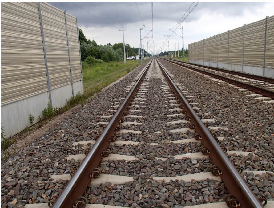
Linia kolejowa nr 6 stacja Łochów i szlak Łochów-Sadowne zmodernizowana w ramach umowy z 2012 r.
