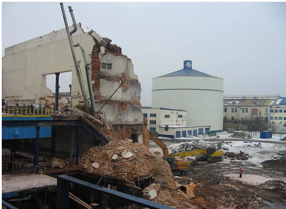
Na zdjęciu: Główny budynek produkcyjny w b. Cukrowni Lublin w trakcie rozbiórki. W głębi silos na cukier luzem, przeznaczony do demontażu. Foto J. Gołębiowski 2010-03-04.
