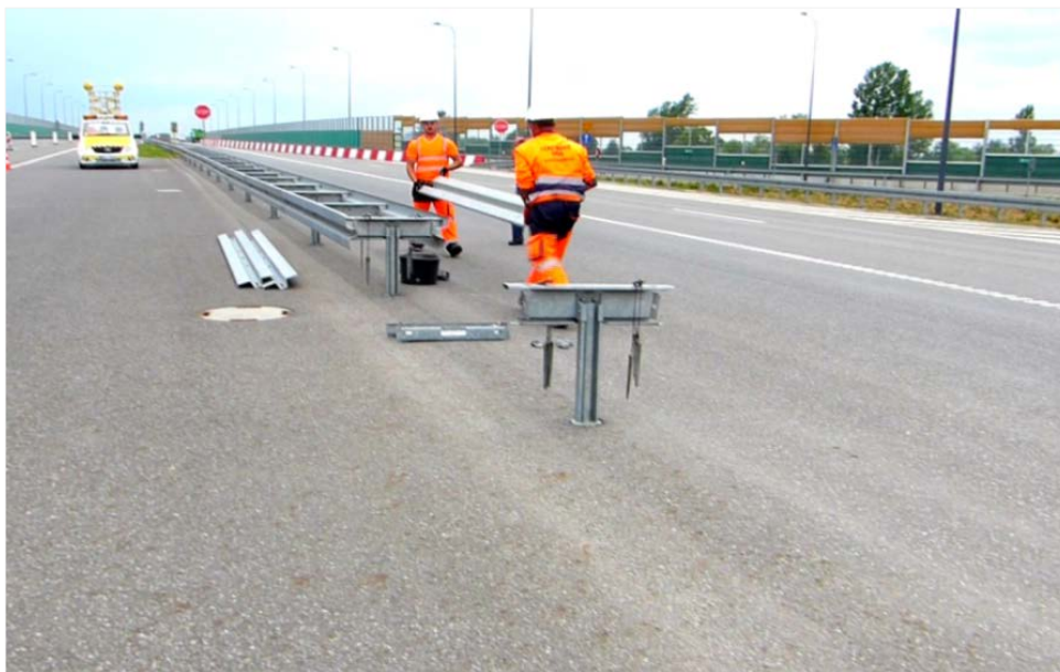
Autostrada A4 w rejonie węzła Rzeszów-Wschód - demontaż bariery klinowej na terenie przejazdu awaryjnego
