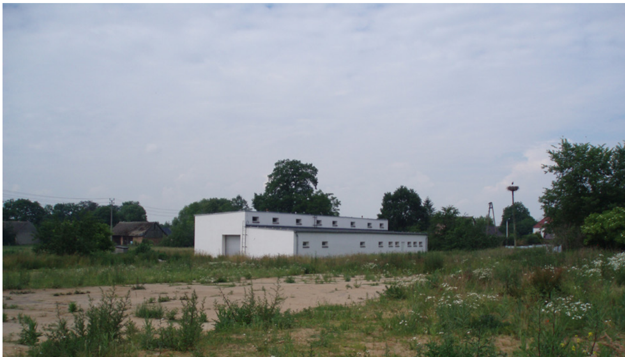
Zdjęcie nr 13 Budynek wyremontowanego cielętnika
