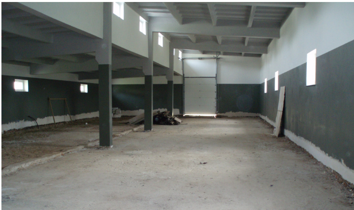
Zdjęcie nr 14 Wnętrze budynku wyremontowanego cielętnika
