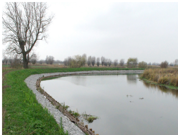
Przebudowane koryto rzeki Dzierzgoń
