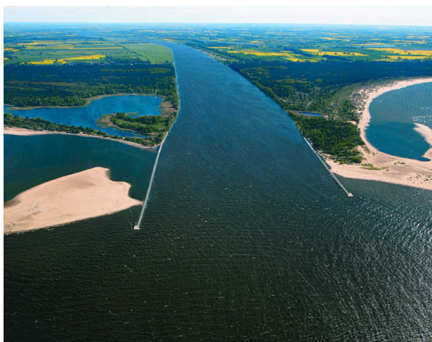
Ujście Wisły po przebudowie
