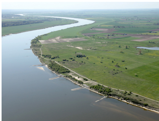
Odbudowane ostrogi na Wiśle
