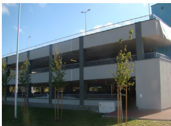
Zdjęcie nr 4 Garaż wielopoziomowy (trójkondygnacyjny)
