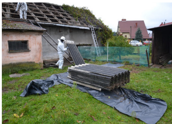
Zdjęcie nr 10 Składowanie zdemontowanego azbestowego pokrycia dachowego
