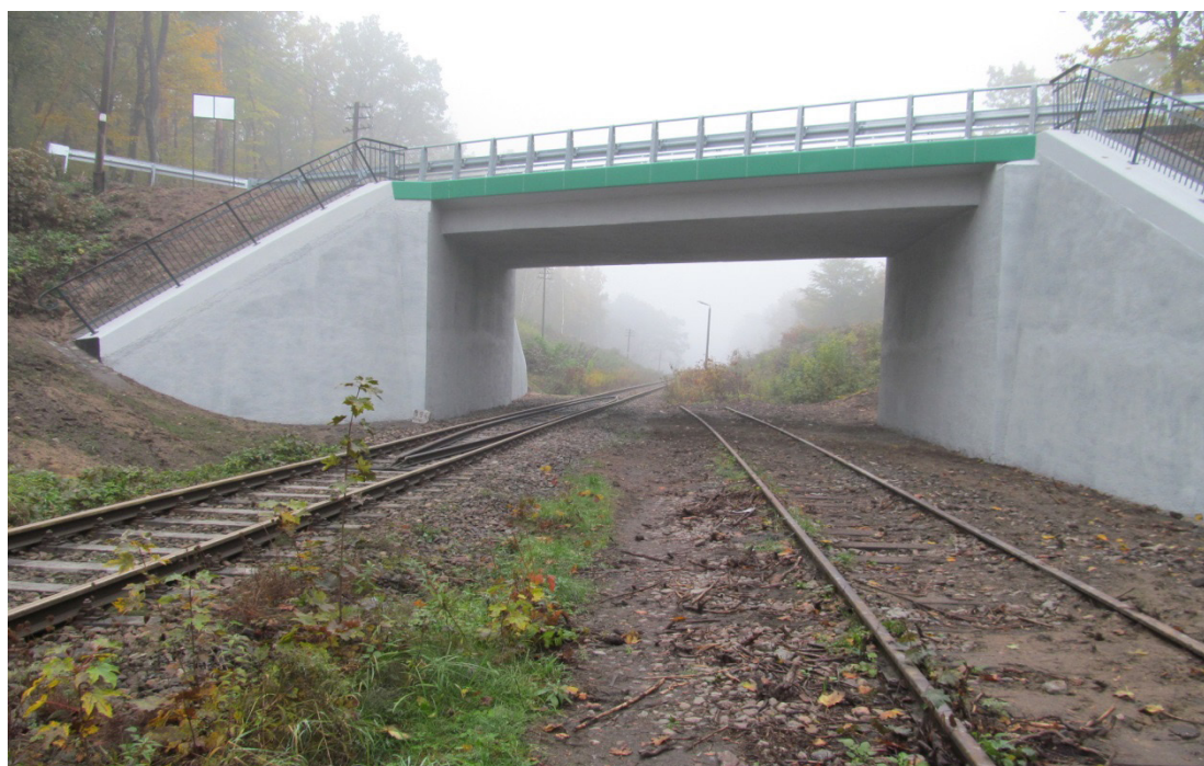
Zdjęcie nr 2 Wiadukt w Brachlewie (w ciągu drogi wojewódzkiej 529)
