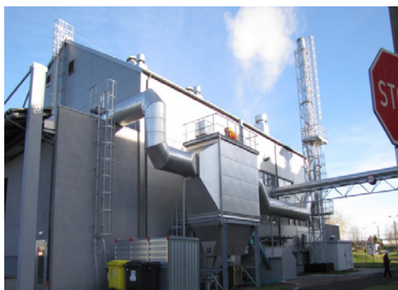
Zdjęcie nr 7 Budynek elektrociepłowni
