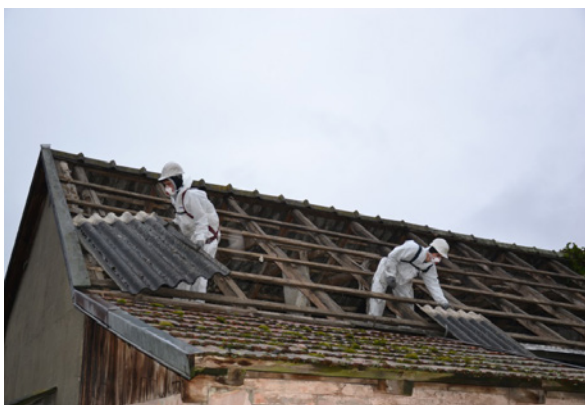
Zdjęcie nr 9 Demontaż azbestowych pokryć dachowych
